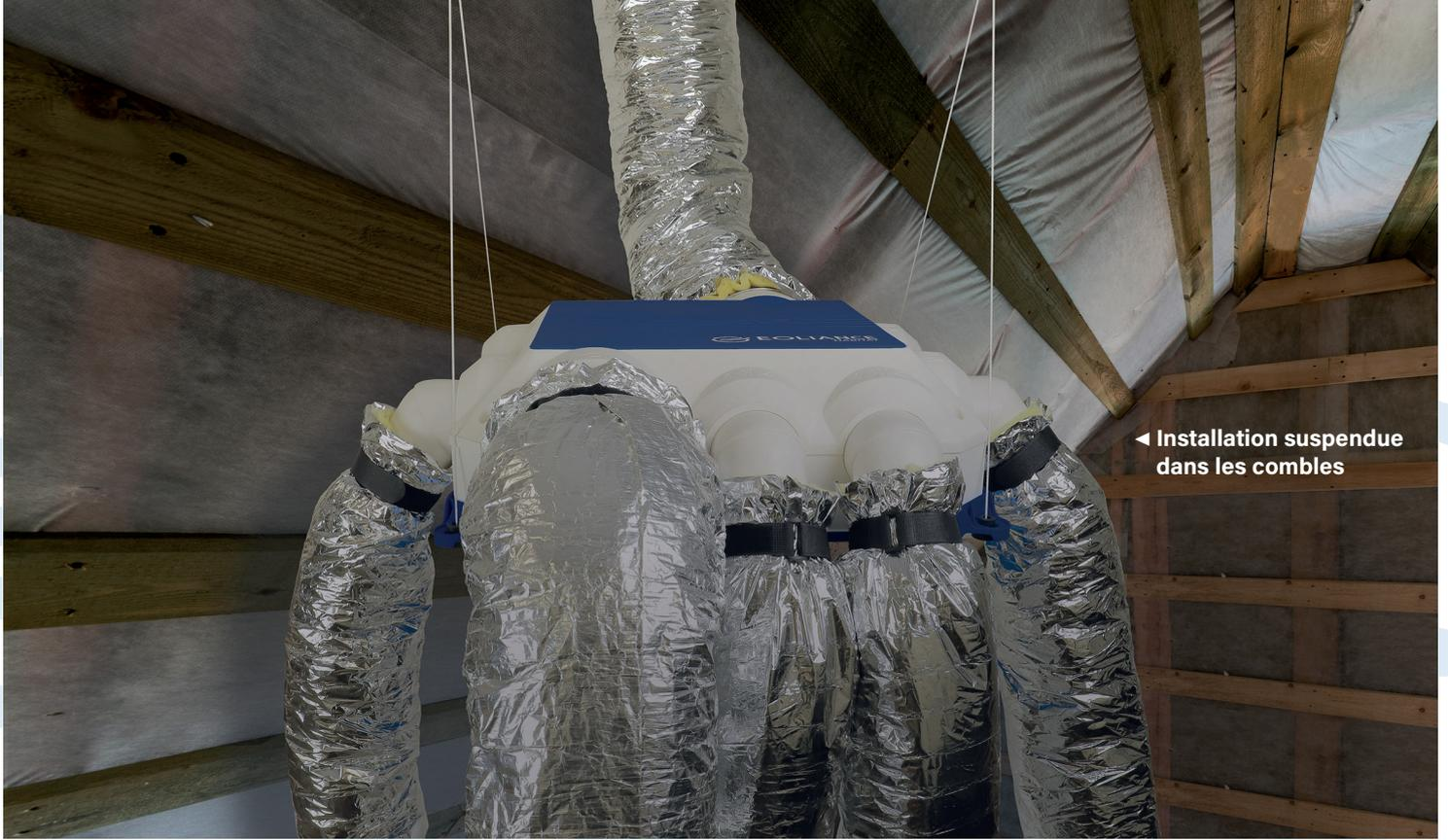
◀ Installation suspendue dans les combles
